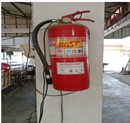
ภาพประกอบ ๔ ถังดับเพลิงติดตั้งภายในอาคารตลาดสด
